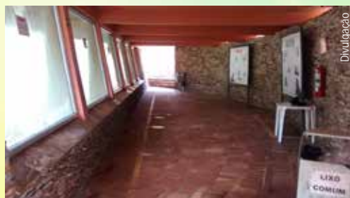
Piso do túnel do Recinto dos Gorilas - DEPOIS
