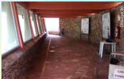
Limpeza do túnel do Recinto dos Gorilas (dia 09/09)
