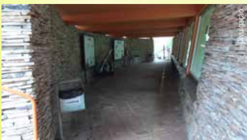
Piso do túnel do Recinto dos Gorilas - ANTES
